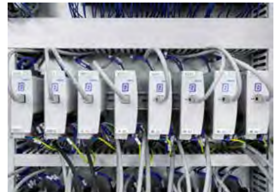
Kontrol kabininde yer alan CMMO-ST serisi kontrol üniteleriyle tahrik paketini hızla işletmeye almak mümkündür.
